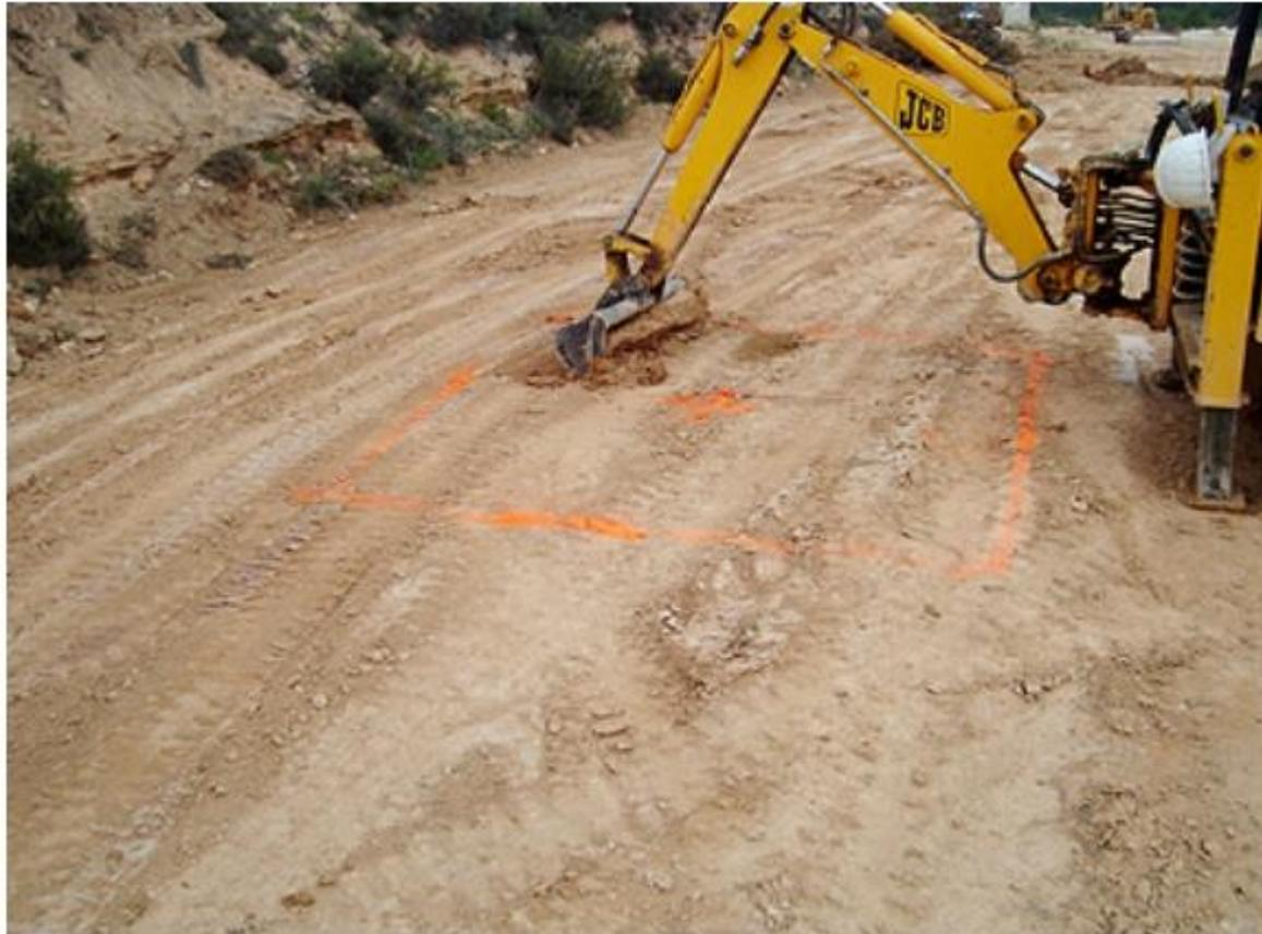
La excavación de los cimientos de un seguidor realizada con una profundidad de 70 cm.
